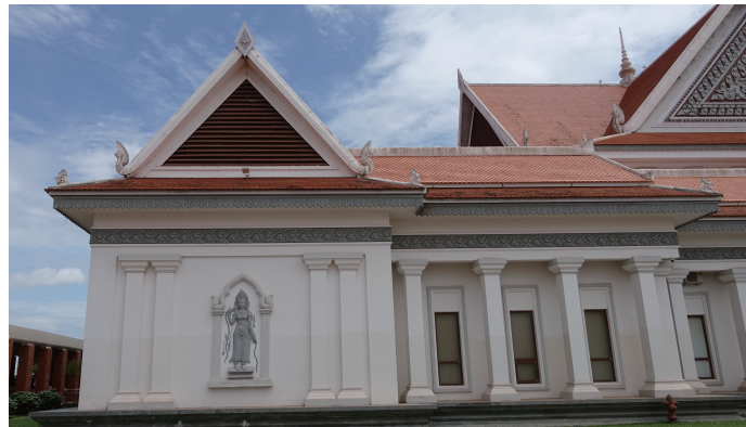
도 4.1 앙코르 전경화관 외벽의 데바타(devata) 장식(직접 촬영)
