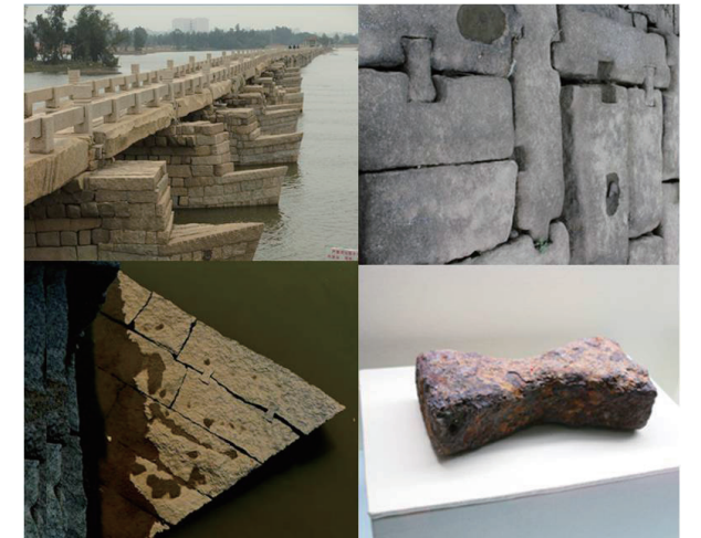
도 6 (좌-상) 중국 낙양교(洛陽橋), 복건 천주. 1053-1059 조성. 현 모습 (좌-하) 낙양교 선수형 교각의 석제 호접형 요철 (우-상) 중국 어량패(漁梁壩)제방, 안휘 황주. 당대 시건. 명대 1605년 중수. 석제 호접형 요철 (우-하) 만리장성, 북경 팔달령 출토. 명대 추정. 호접형 요철. 중국장성박물관 소장
