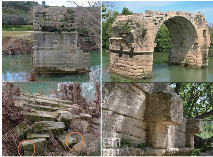
도 11 (상-좌-우) 프랑스 앙부르와교(Pont Ambroix), 1st c. BCE. 로마가 건설한 도미티아가도(Via Domitia) 상의 로마다리. 현재 프랑스 국경 안에 있음. 선수형 교각 (하-좌) 원표시안의 연미형 은장흙 (하-우) 썩기돌들의 모습
