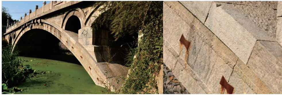
도 4 (좌) 중국 영통교(永通橋), 하북 조현. 7-8세기경 조성. 철제 연미형 요철; (우) 세부
