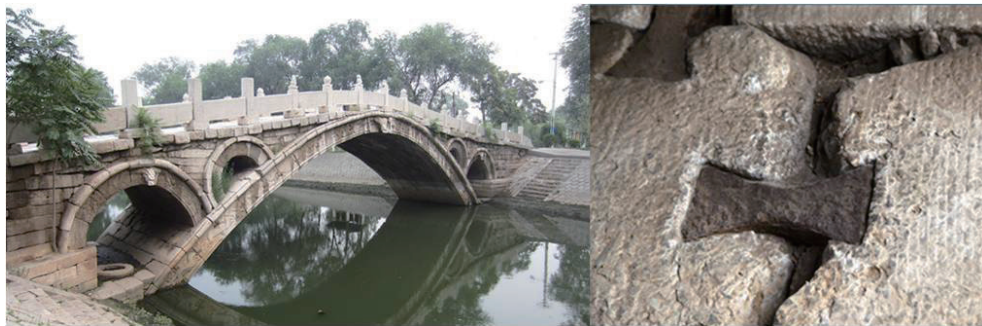
도 5-1 (좌) 중국 홍제교(弘濟橋), 하북 한단. 명대 1444년 1차 중수기록; (우) 홍제교 세부. 철제 연미형 요철
