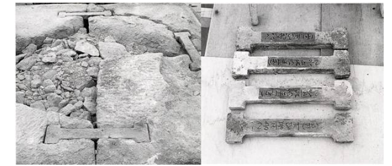
도 4-2 (상) 감은사지 동탑 3층 옥개석. 철제 방두형 은장 도 4-3 (하) 감은사지 동탑 2층 옥개받침석. 상면 은장 결구상태(현장사진)(좌) 동탑 2층 옥개받침석 수습 은장(우)
