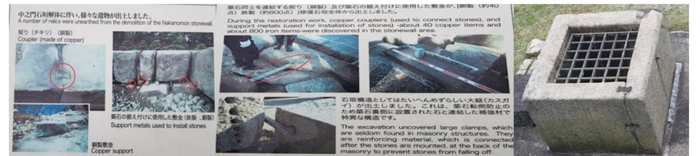
도 1-2 동경 황거. 추정 동제 호접형 은장(황거내야의전시장 자료)(좌) 동경 황거. 근대기 보강 철물들(야외전시장 자료)(중) 동경 황거. 천수각 유지에서 발견한 석정의 호접형 은장, 17세기 추정(우)
