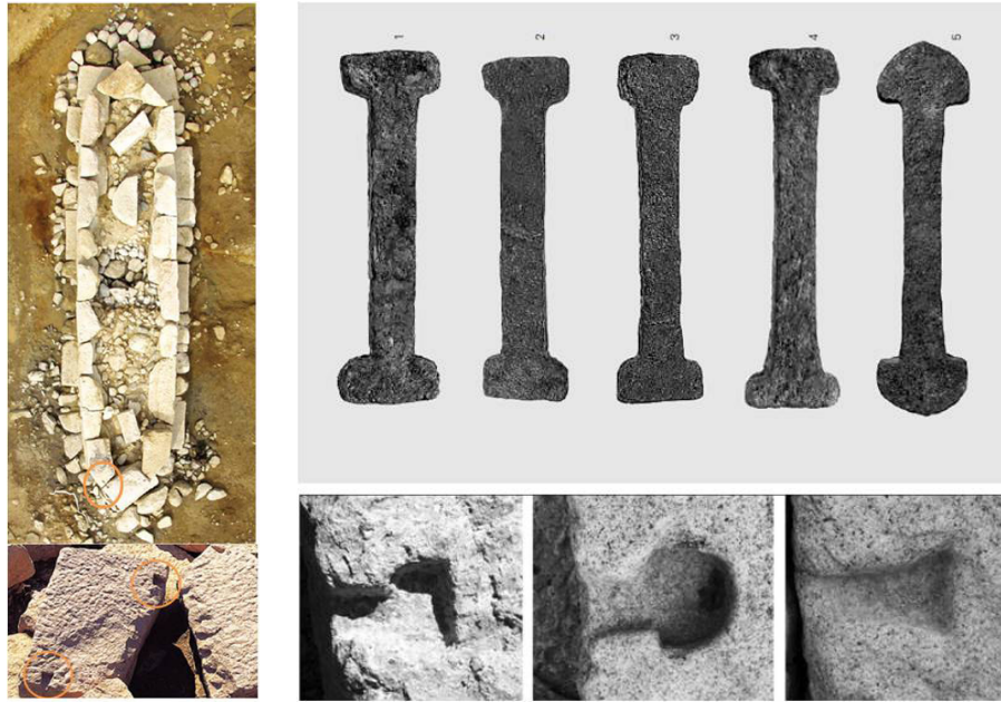
도 11-1 (좌) 춘양교 3호 교각지(상) 춘양교 3호 교각지(남편), 연미형 은장흙(하) 도 11-2 (우) 춘양교 3호 교각 출토 방두형과 반원두형 은장(상) 춘양교 3호 교각 석재 은장흙, 좌측부터 방두형, 반원두형, 연미형(하)
