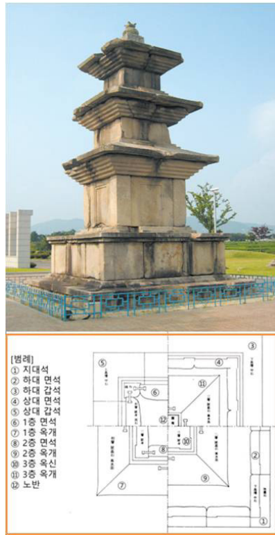
도 6-1 (좌) 고선사지삼층석탑. 682-686년 조성. 현 국립경주박물관 옥외전시(상) 고선사지삼층석탑 전체의 은장배치 평단면도(실제 형태는 방두형이고 철제임)(하) 도 6-2 (우) 나원리오층석탑. 700년전후 조성(상) 나원리오층석탑 1층 탑신받침 방두형은장홈(하)
