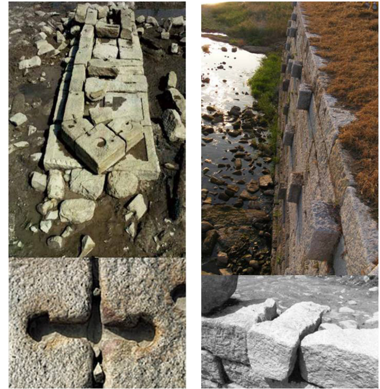
도 10-1 (좌) 월정교지 교각(선수형) 기초부 노출 모습(상) 월정교지 교각 반원두형 은장흙(하) 도 10-2 (우) 월정교지 북편교대 석축의 썸기들(상) 월정교지 북편교대 석축의 썸기들세부(하)
