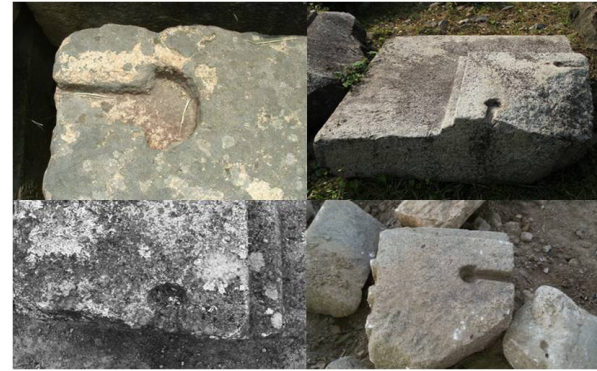
도 8 장항리사지 석탑 기단면석 은장홈(반원두형)(좌·상) 전 인왕사지 석탑 하층기단갑석(반원두형)(좌·하) 구황동사지 석탑 기단갑석 은장홈(반원두형)(우·상) 호원사지 석탑 기단갑석 석재 은장홈(반원두형)(우·하)
