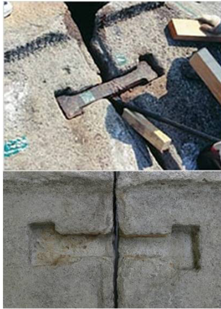
도 5-1 감은사지서석탑은장수거작업(상) 감은사지서석탑3층옥개석(서면)은장홈(하)
