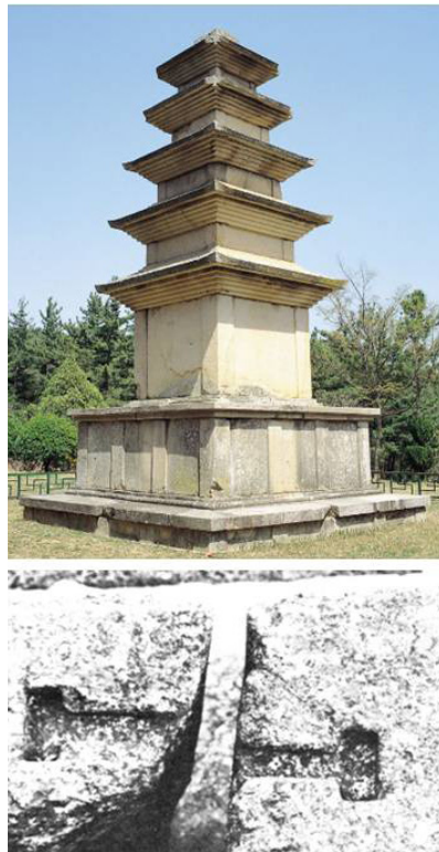
도 6-1 (좌) 고선사지삼층석탑. 682-686년 조성. 현 국립경주박물관 옥외전시(상) 고선사지삼층석탑 전체의 은장배치 평단면도(실제 형태는 방두형이고 철제임)(하) 도 6-2 (우) 나원리오층석탑. 700년전후 조성(상) 나원리오층석탑 1층 탑신받침 방두형은장홈(하)
