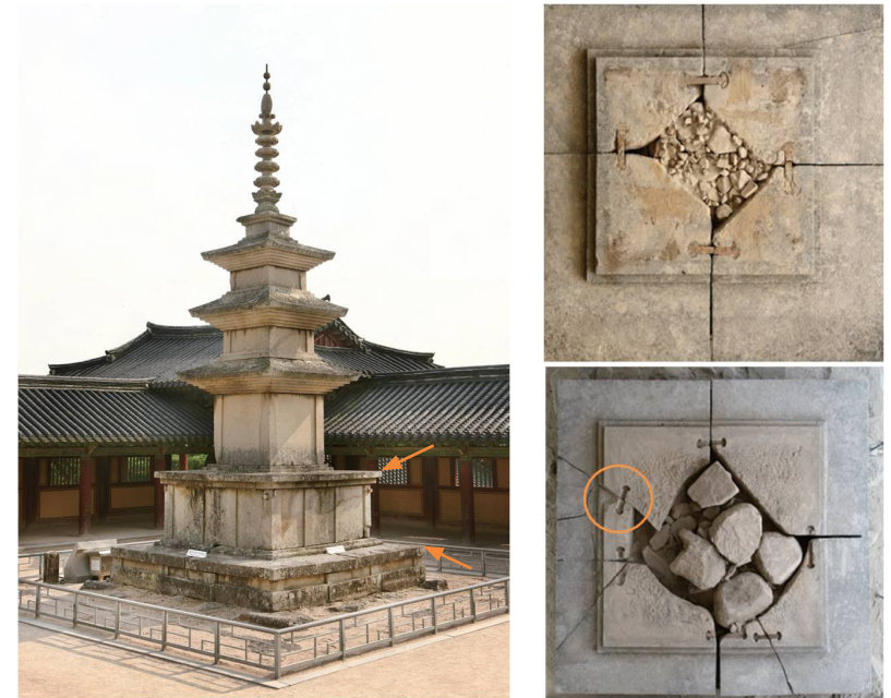
도 7-1 (좌) 석가탑. 8세기 중엽 조성. 2012년 모습 도 7-2 (우) 석가탑 상층기단갑석(위 화살표) 네 지점 은장 배치(상) 석가탑 하층기단갑석(아래 화살표) 여섯 지점 은장 배치(하)
