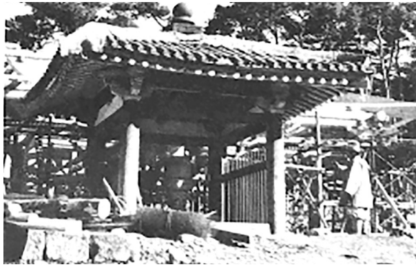
도 19 불국사 사리탑 보호각 해체 모습, 1971.3.8 (『불국사 복원 공사 보고서』(문화공보부 문화재관리국, 1976), p.166).
