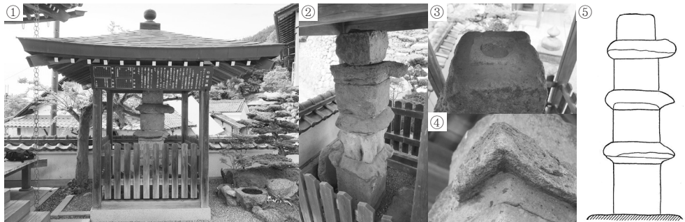
도 7 龍福寺石塔 ①·②전경, ③최상층 옥개석 윗면, ④3층 옥개석 모서리 아랫면 ⑤실측도(奈良縣編, 1914, 第4圖, 필자 수정)
