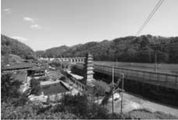
도 15 낙동강(앞)과 협소한 지세(뒤) 사이에 신세동 칠층전탑
