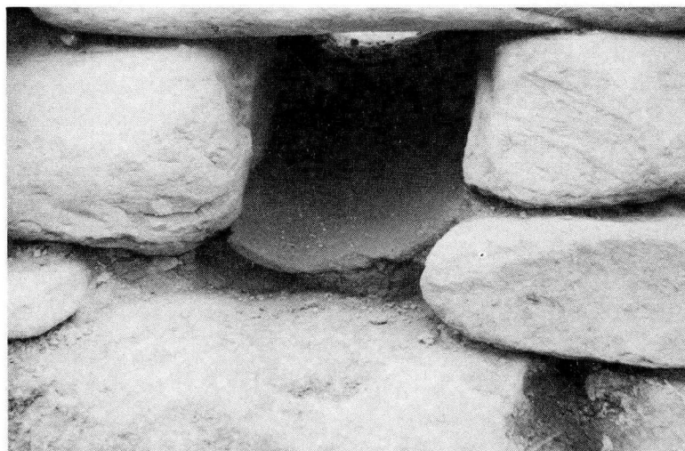
③ 排水施設 流出口
