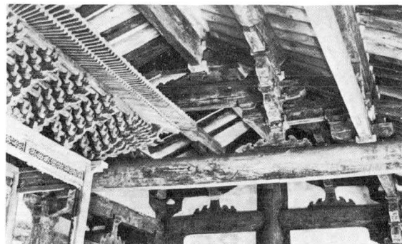
〈圖 3〉鳳停寺 極樂殿 內部 架構
