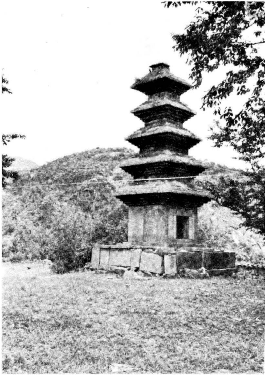
圖 27) 義城冰山寺址 五層石塔
