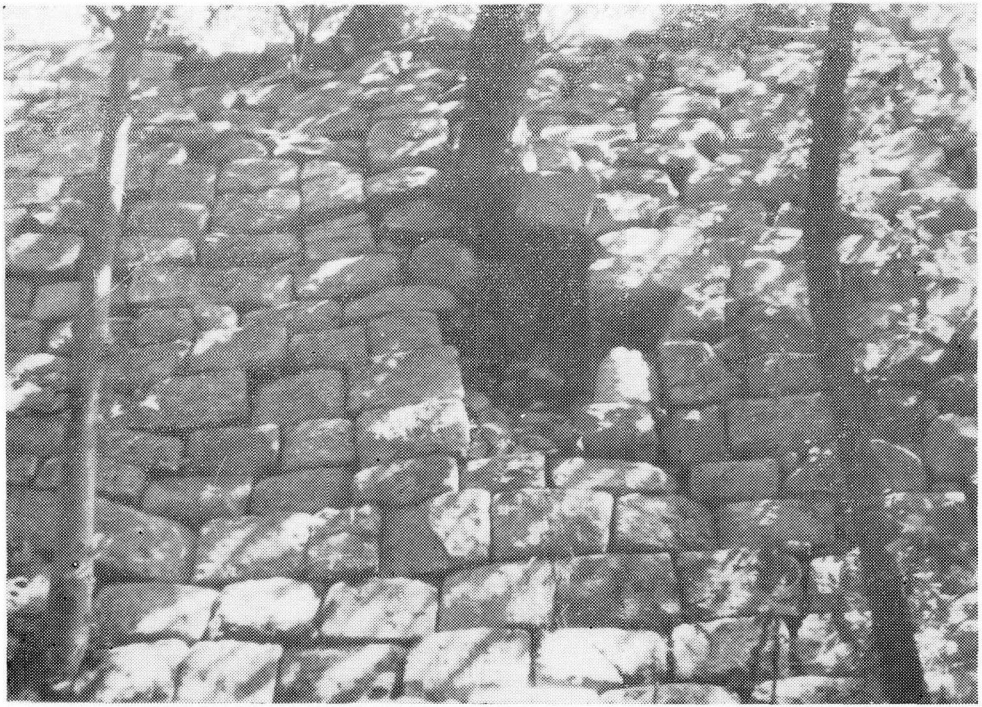
圖 2 石城構築狀態(鎮南樓~東門址間)
