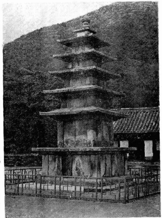
完工된 無量寺 五層石塔
