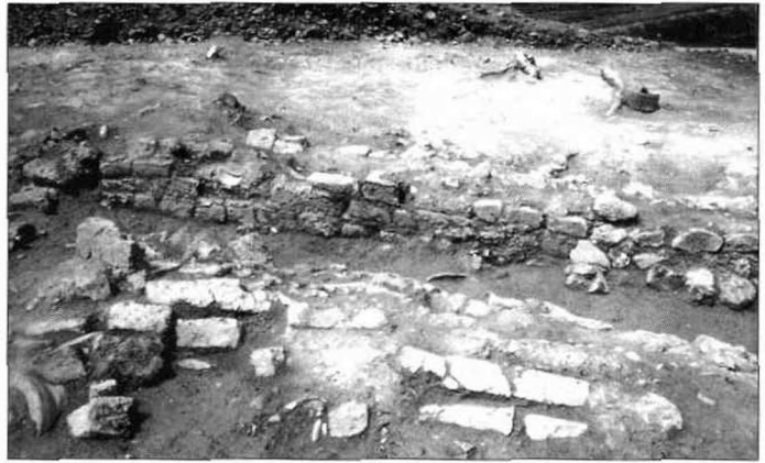
圖 10. '芳山大窯'의 측면窯壁. 塼築窯는 내벽과 외벽까지 완전히 벽돌을 쌓아 축조하였으며, 보수 또는 개축할 경우에도 한번 사용했던 벽돌을 재활용하여 쌓는 것이 원칙이다.
