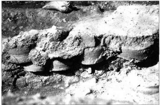
圖 9. 土築窯인 강진 용운리 10-1호요의 側面壁. 주로 耐火粘土를 사용하지만 벽의 중심부에는 廢匣鉢을 모감재로 사용한 경우도 있다.
